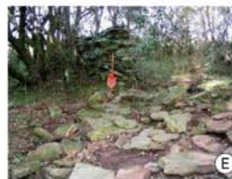
Détail d'un muret
