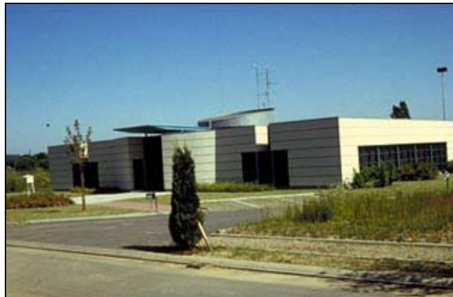
Figure III.5 : Station de mesure des COV de Schiltigheim
