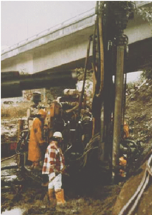
Pont sur l'autoroute I-110 à USA (FHWA 2000).
