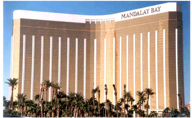
Renforcement par Micropieux du Casino Mandalay à Las Vegas (ASCE News 2001).
