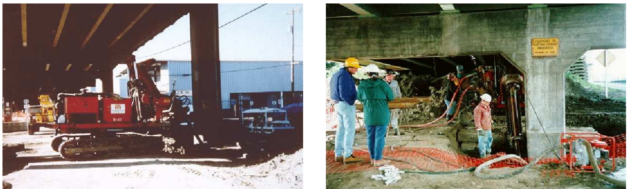
Figure 1.4. Réalisation du renforcement de deux ponts avec de micropieux (FHWA 2000).
