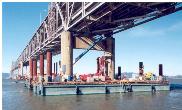
Pont de Richmond San Rafael à USA, (Ben C. Gerwick, Inc, 2004).
