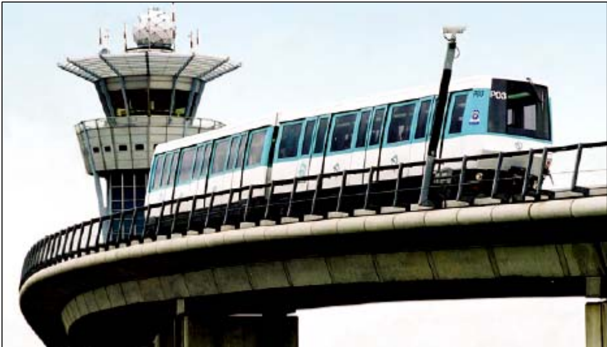
Photo 2-6 : Rame du métro automatique OrlyVAL sur viaduc [ART2.C.II].
