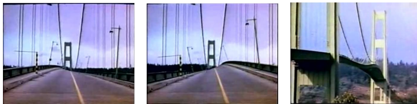
Fig. 5 – Les oscillations du pont de Tacoma qui ont provoqué sa destruction en 1940.
