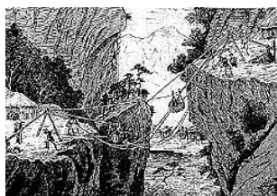
(a) Traversée de torrents
