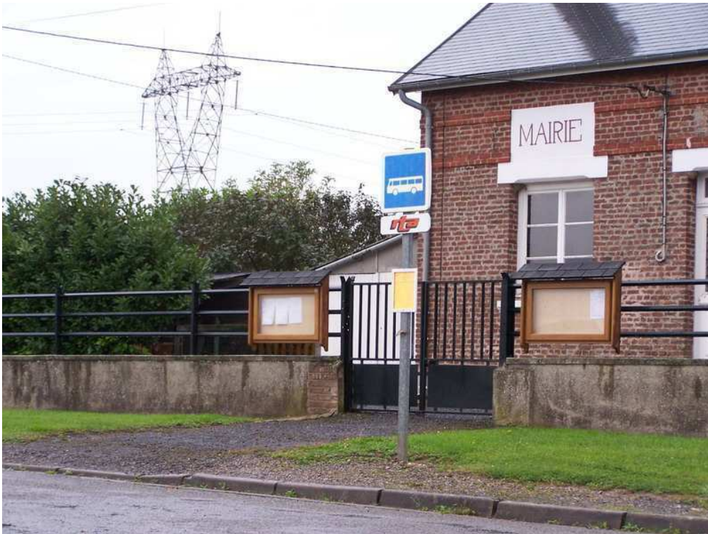
Le point d'arrêt de Cerizy : ici, les élèves doivent attendre l'autocar debout et n'ont aucun moyen de s'abriter de la pluie, du vent... Photo : Stéphane GODEFROY, 2006.
