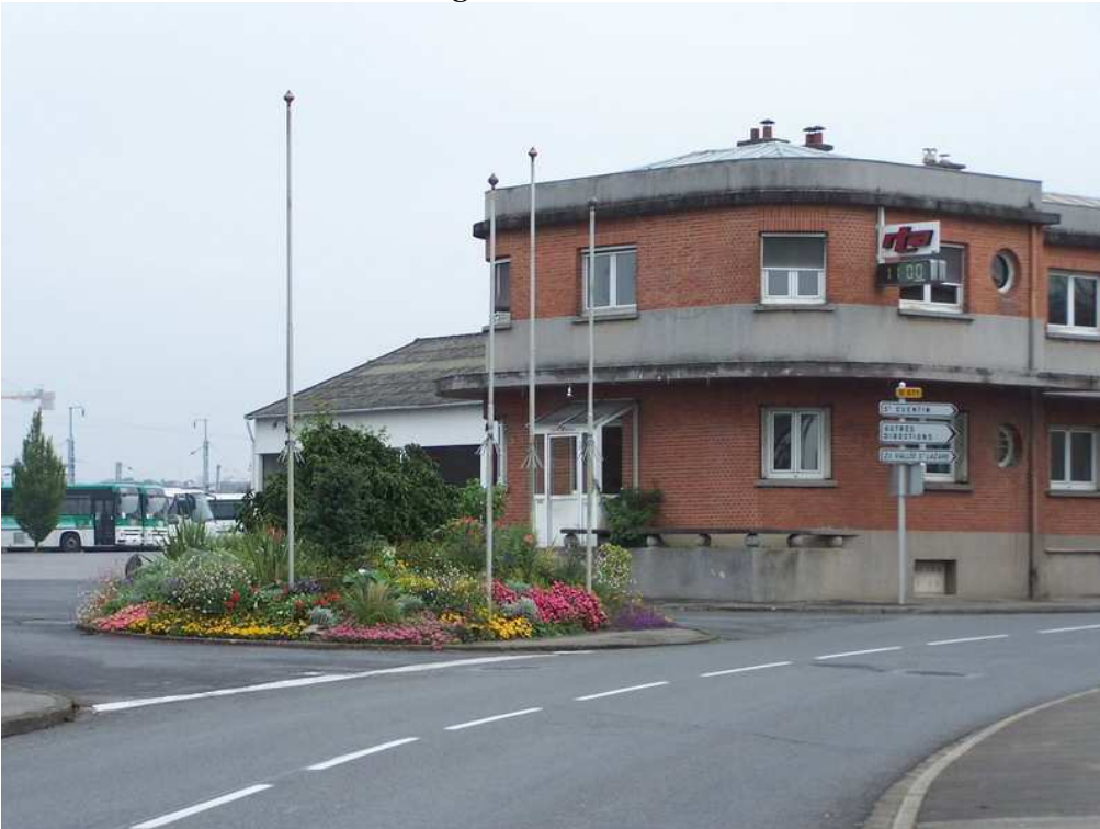
Le siège de la Régie Départementale des Transports de l'Aisne à Gauchy. La RTA est un Établissement Public Industriel et Commercial (EPIC), à qui le Conseil Général a confié l'exploitation de services réguliers de transport de voyageurs. Photo : Stéphane GODEFROY, 2006.
