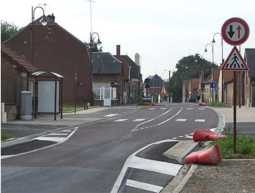
La sécurisation du nouvel arrêt de la commune de Brissay-Choigny : un rétrécissement de la chaussée, une zone limitée à 30 km/h, un dégagement de part et d'autre de la chaussée pour le stationnement de l'autocar, des passages pour piétons....
