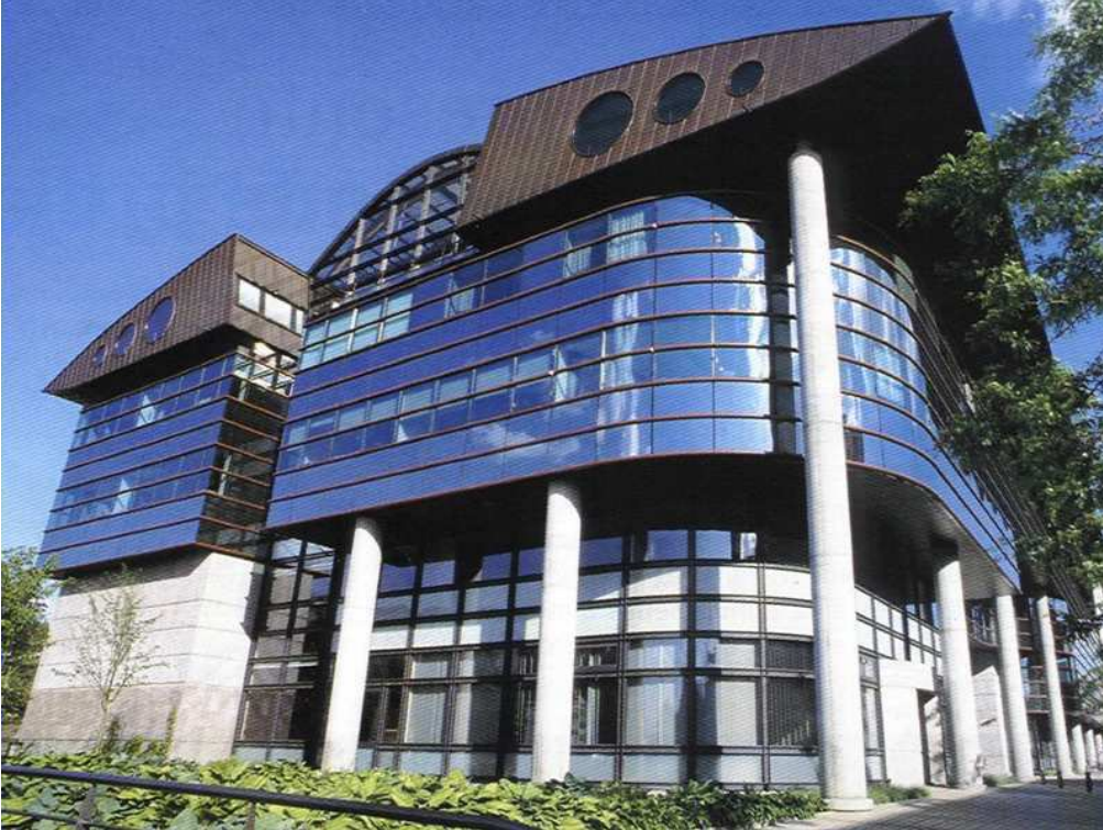
Le bâtiment qui abrite la Communauté d'Agglomération du Pays de Montbéliard, autorité organisatrice du transport scolaire au sein de la CAPM. Photo : CAPM, 2001.
