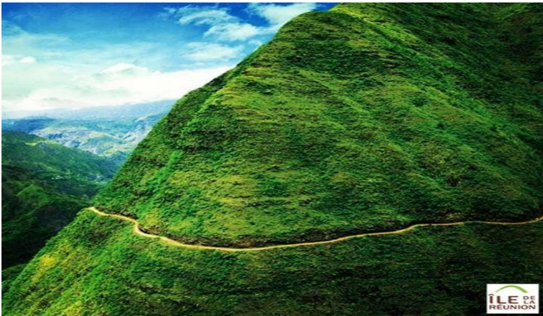
Figure 6 : vue aérienne de la canalisation des orangers
