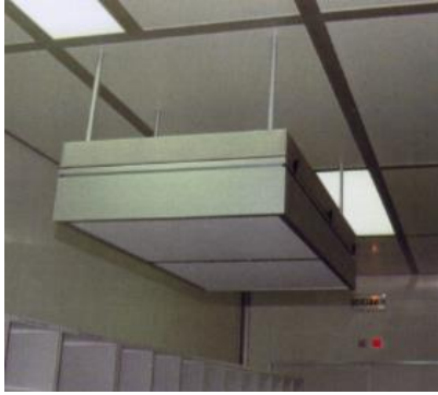
Figure 12 : Photo et schéma d'un FFU
