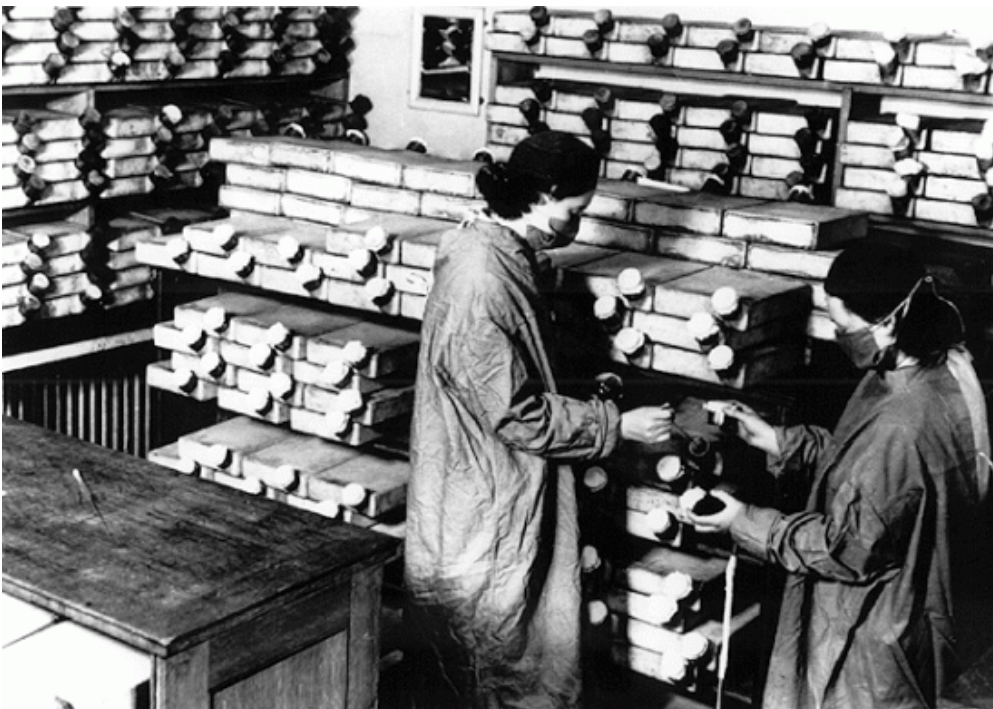
Figure 108. Production de pénicilline dans les années 1940, culture en surface dans des fioles de Roux. Source : http://lesantibiotiques-lapenicilline.e-monsite.com/pages/i-la-fabrication-des-antibiotiques.html
