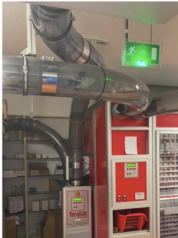
*Figure 8 : Photo montrant la sortie du système de convoyage (Tecnilab)*
