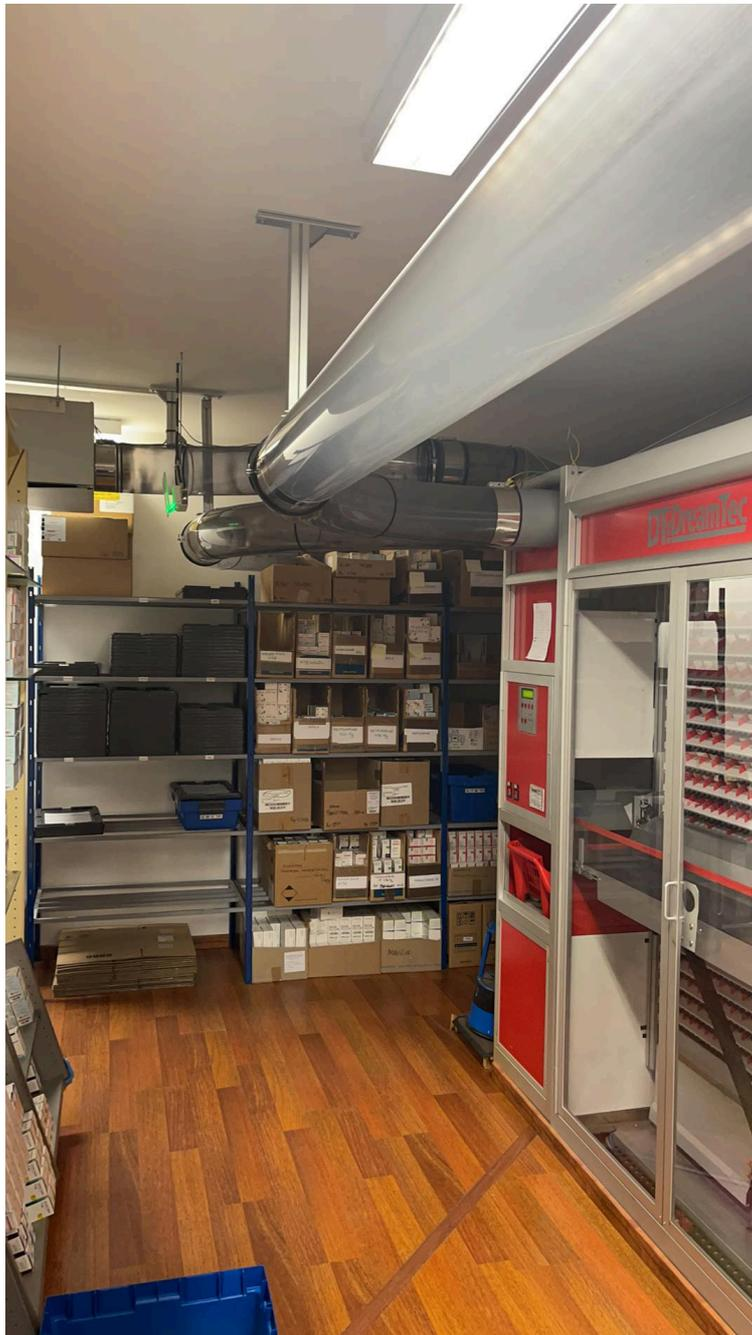
*Figure 9 : Photo montrant le système de convoyage (Tecnilab)*
